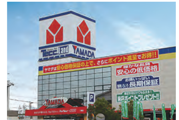
▲ 協業先例: ヤマダ電機様外観
